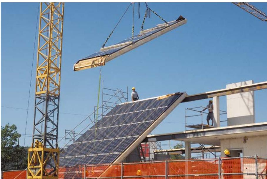
Speziell an der Anlage sind die Solarpanels, welche gleichzeitig die Dachfunktion übernehmen.
