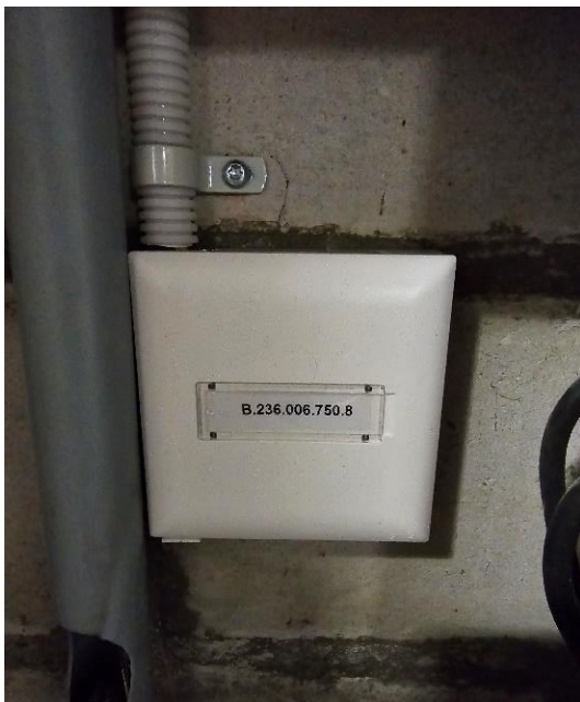
Abbildung 3 und Abbildung 4: G-OTO Installation Hauptverteilung
