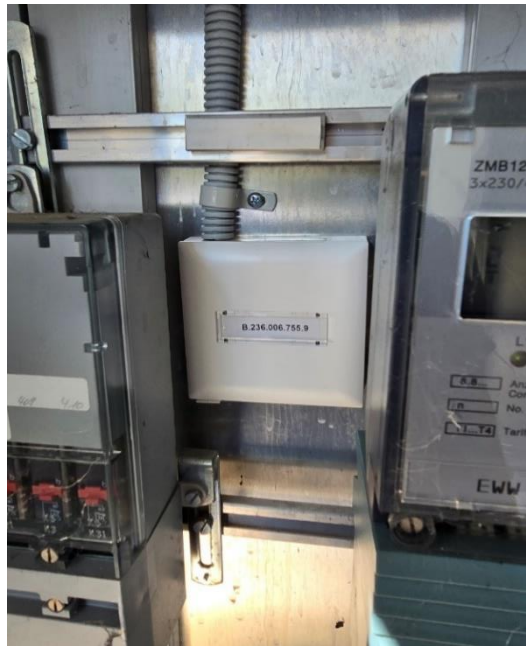
Abbildung 1 und Abbildung 2: G-OTO Installation Anschlusskasten aussen
