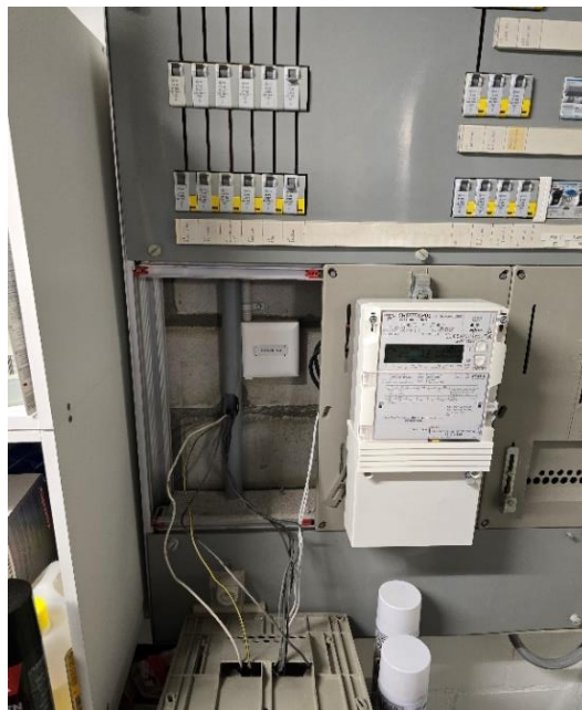
Abbildung 1 und Abbildung 2: G-OTO Installation Anschlusskasten aussen
