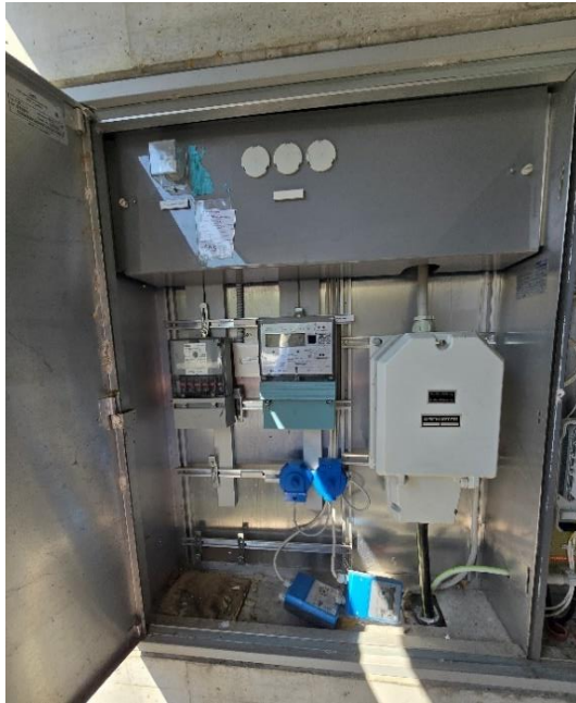
Abbildung 1 und Abbildung 2: G-OTO Installation Anschlusskasten aussen
